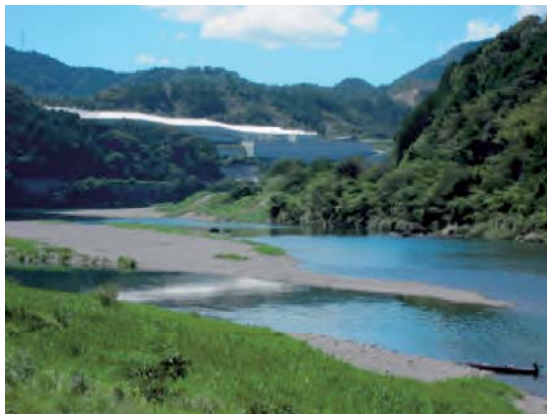
管理型最終処分場「エコサイクルセンター」
