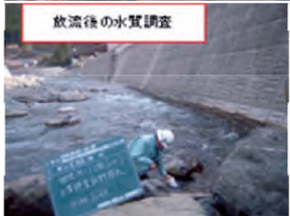
(写真2) 工事排水は濁水処理をした後、河川へ放流した。
