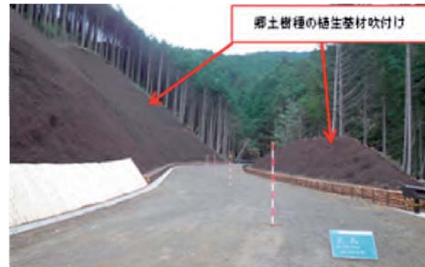
(写真4) 山切面には郷土種による植生基材吹付工を採用
