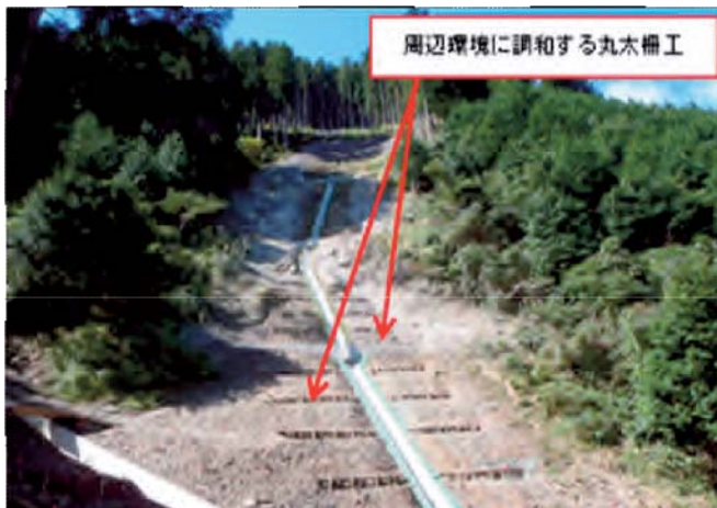
（写真6）周辺環境に配慮した丸太柵工による緑化
