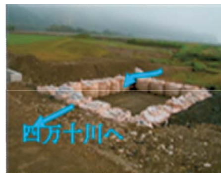
（写真9）沈砂池の設置による濁水の軽減
