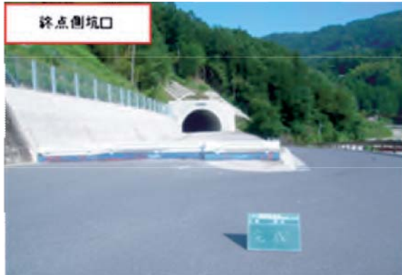
(写真1) 地形改変の少ないトンネル坑口構造と周辺景観と調和した緑化工法の採用
