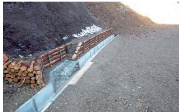
(写真5) 小動物の出入りが可能な側溝を採用
