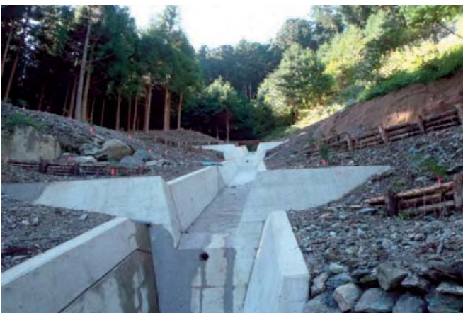
（写真7）周辺環境に配慮した丸太柵工による緑化
