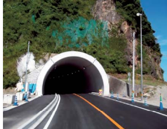
(写真3) 坑口を突出型とすることにより圧迫感を軽減させるデザインを採用
