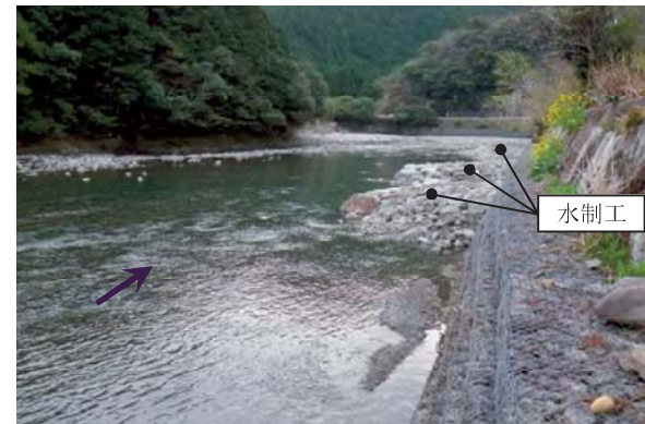
工事完了直後（H24. 3 月）
