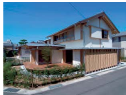
木造住宅(外観)
