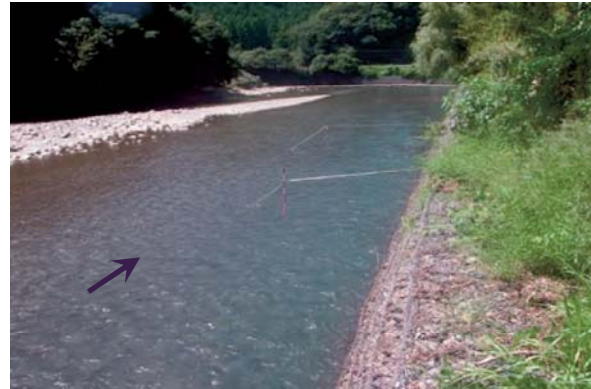
着工前（伊尾木川：安芸市大熊）
