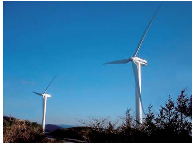
甫喜ヶ峰風力発電所（香美市土佐山田町）
