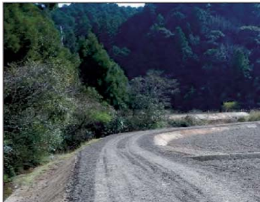
(写真9) 盛土工土羽による管理道を設置し、谷川を保全
