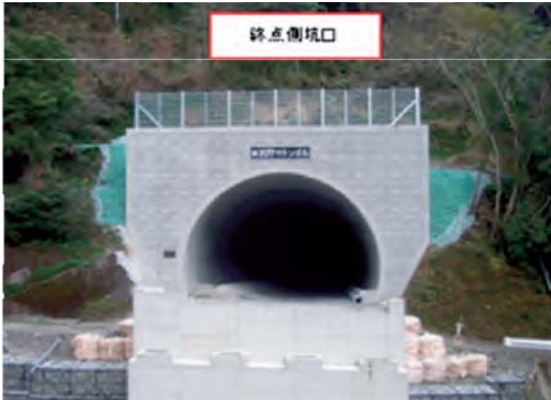
(写真 1) 地形改変の少ないトンネル坑口構造と周辺景観と調和した緑化工法の採用
