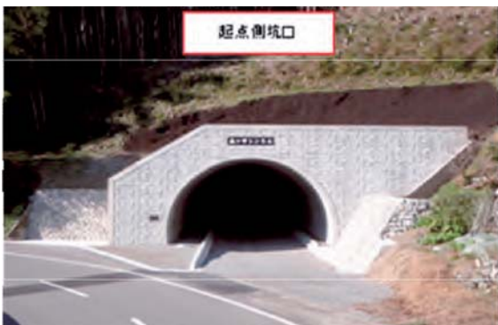
(写真 2) 周辺環境に配慮した坑口の面壁デザインと石積みを採用
