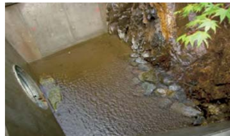
(写真 5) 集水ますの一部に石積みを設置
