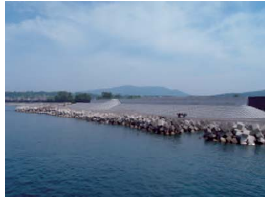
(写真 3) 既設ブロックを汚濁防止対策に利用
