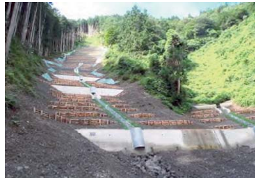
(写真 4) 周辺環境に配慮した丸太柵工による緑化
