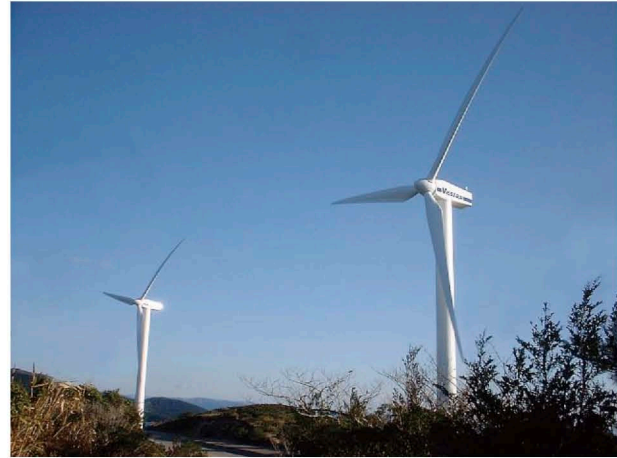
浦喜ヶ峰風力発電所（香美市土佐山田町）
