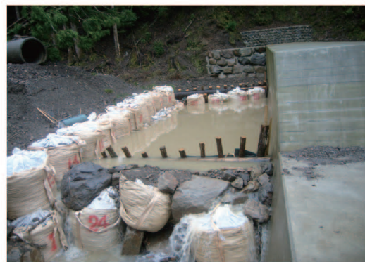
(写真4)河川への濁水防止のため沈殿池を設置
