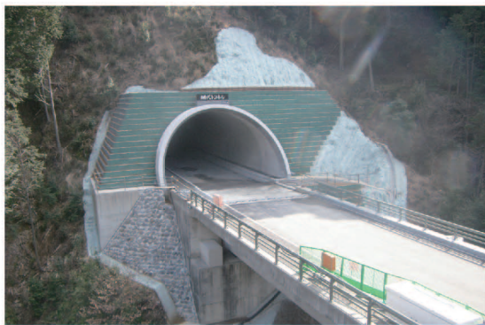
(写真1)周辺景観と調和したトンネル坑口デザインの採用
