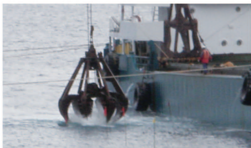
(写真2)水面に極力近づけた捨石投入
