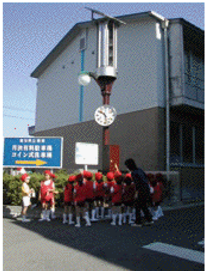
公営企業局総合制御所（高知市鴨部）
