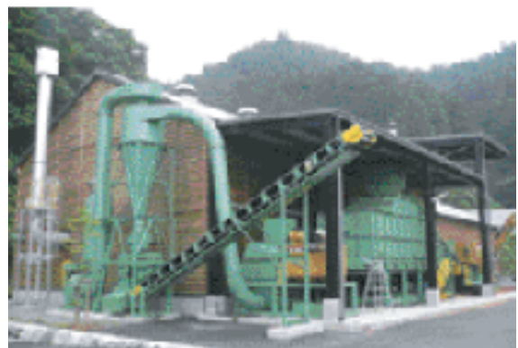
木質ペレット製造工場（梶原町）
