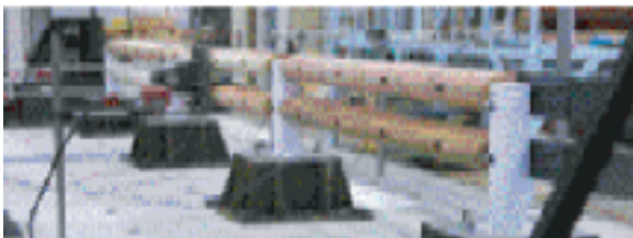
木製ガードレール
