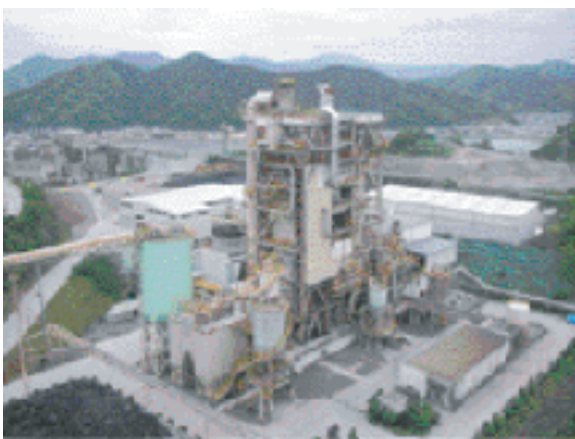
木質バイオマスを利用した発電施設
