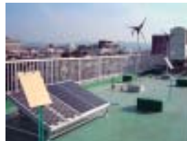
○ソーラ発電・風力発電装置
