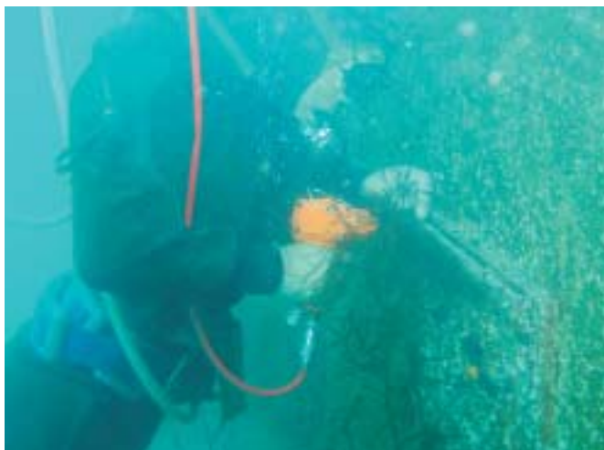
海藻スティック取付け状況
