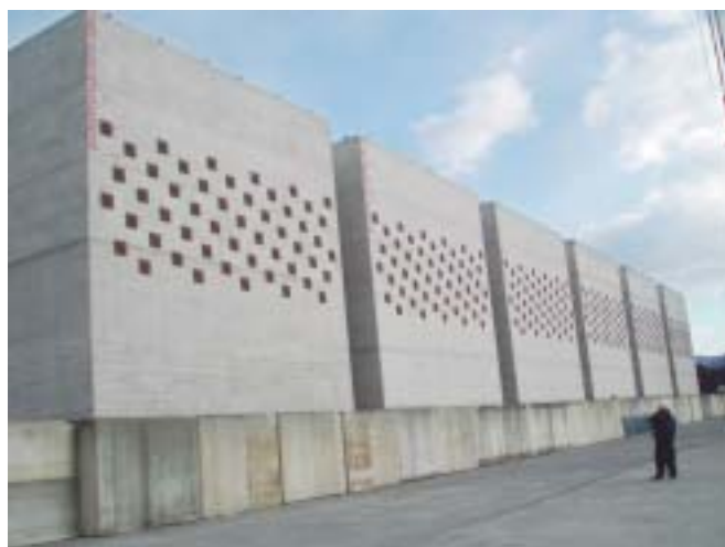
ケーソンへの海藻プレート取付け完了
