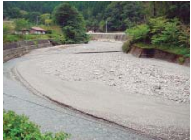
被災直後（土砂により埋塞した川の滞筋）
