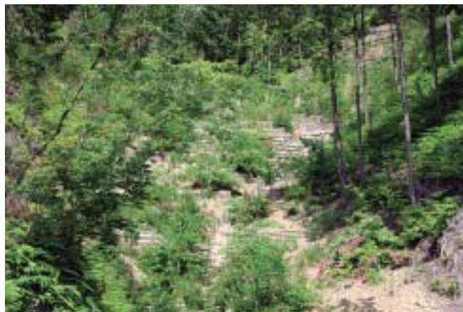
治山施設施工後に植栽を実施
