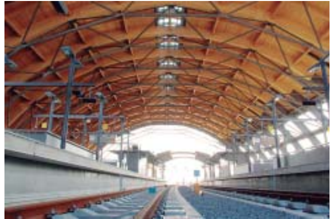
県産木材で整備されたJR高知駅舎の大屋根（くじらドーム）
