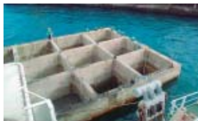
ケーソン内排水状況
