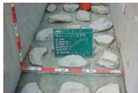
落差部分をスロープ状にし、現地石を配置(写真上)
