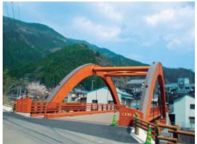
木製車道橋（梶原町）
