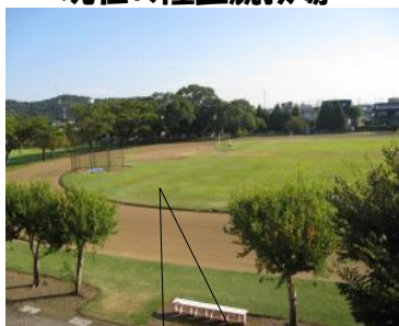
土質・芝が剥離状態
