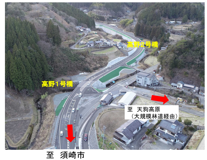
③ 津野町側 現道との交差点付近
