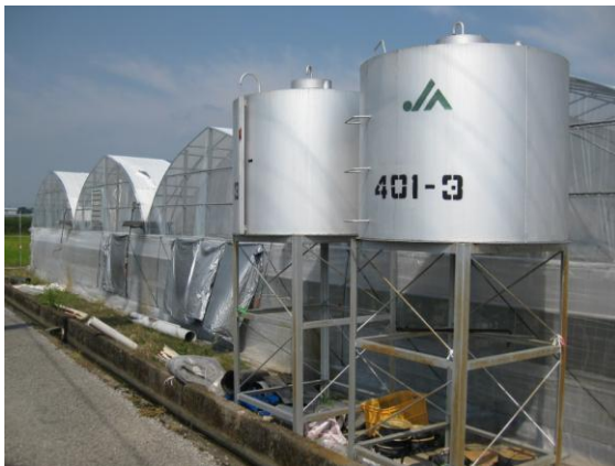
A重油を使用しているハウス
