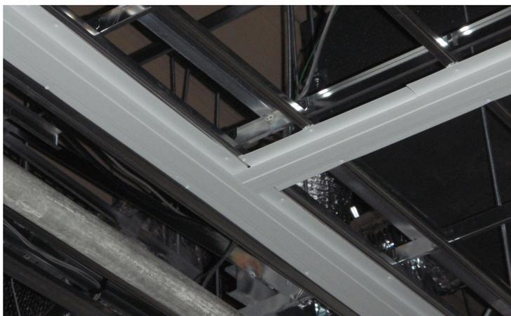
耐震天井廻り縁を使用することにより、壁部材と天井部材を離して設置することができます。このため、地震の揺れによって、壁部材と天井部材が互いに衝突して破損することを防止できます。
