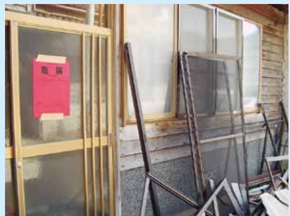
被害住家と被災建築物応急危険度判定結果 (提供：一般財団法人 消防科学総合センター)
