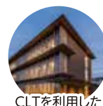
CLTを利用した木造建築物(高知学園大学)
