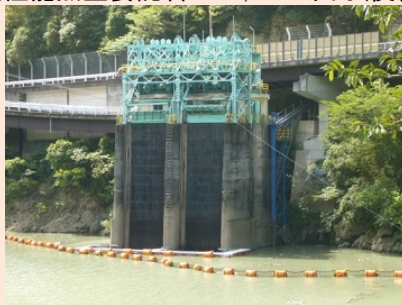
永瀬発電所 取水口
