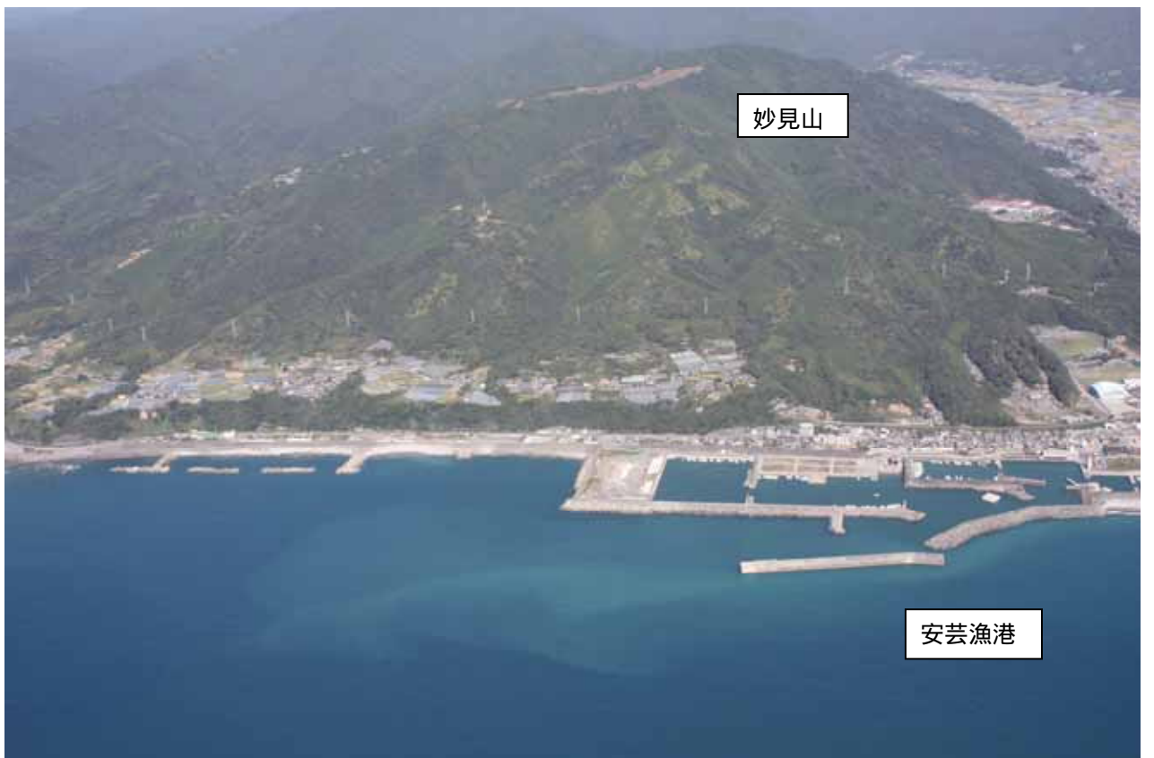
西浜海岸～安芸漁港(安芸市)
