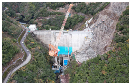
和食ダム建設
