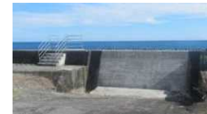
コンクリートによる陸こうの閉鎖
