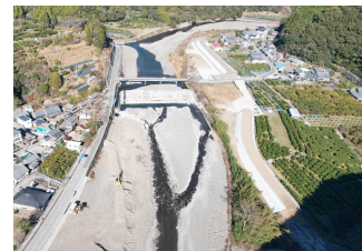
【安芸川】 (河川の堤防整備)
