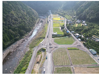
【北川道路 2-2工区】 (8の字ネットワークの整備)
