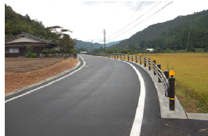
県道西土佐松野線における1.5車線整備
