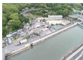
河川堤防の耐震対策
