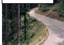
林道開設施工後
