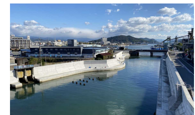
【高知港海岸】 (海岸堤防の耐震対策)
