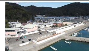
海岸堤防の耐震対策
