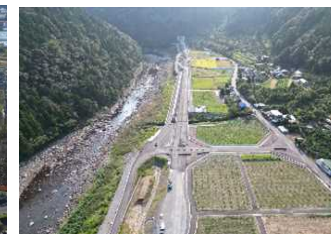
国道493号 (北川道路2-2工区)
