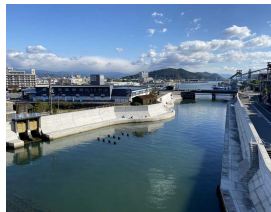
海岸堤防の耐震対策
