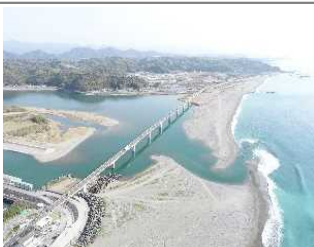
県道須崎仁ノ線(仁淀川河口大橋)
