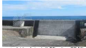
コンクリートによる陸こうの閉鎖
