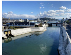
海岸堤防の耐震対策
