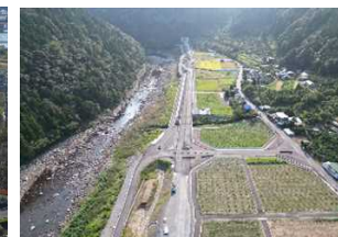
国道493号 (北川道路2-2工区)
