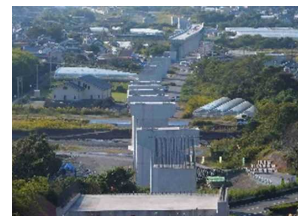
高知東部自動車道 南国安芸道路(安芸市)
