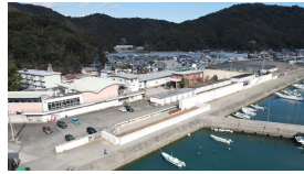
海岸堤防の耐震対策
