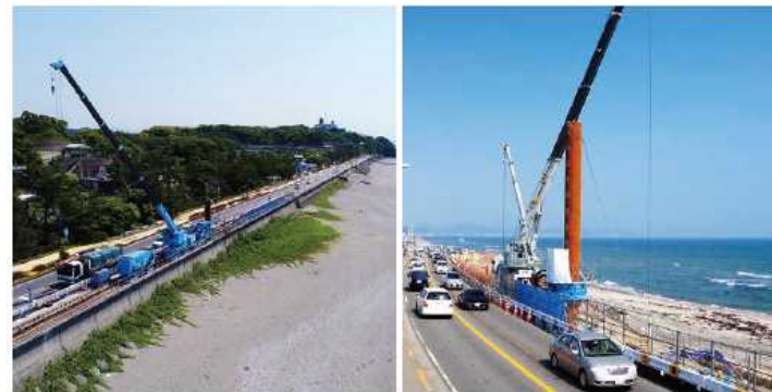
堤防補強技術
