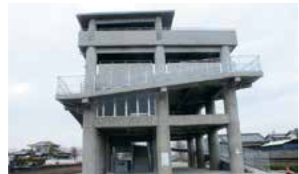
南国市津波避難タワー
