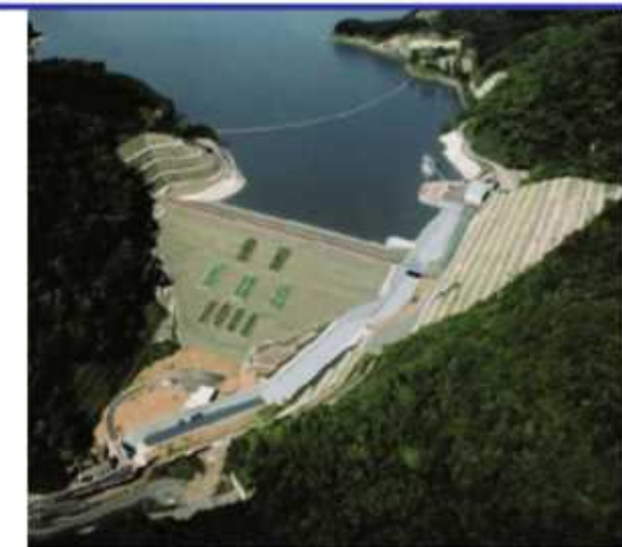
【平成13年完成の山王海ダム】
