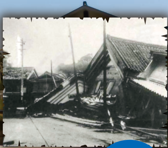
昭和南海地震発生後の様子
