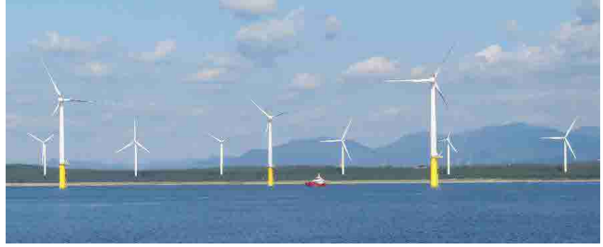
運転中の洋上風力発電事業(秋田港内)
