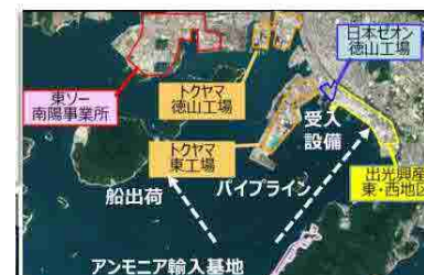
カーボンニュートラルポートの形成に向けた検討(山口県: 徳山下松港)
