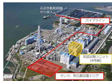
アンモニア混焼実証事業が行われる 愛知県碧南火力発電所 出典: JERA資料から国土交通省作成
