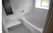
空き家リノベーションによる移住促進 (長崎県小値賀島)
