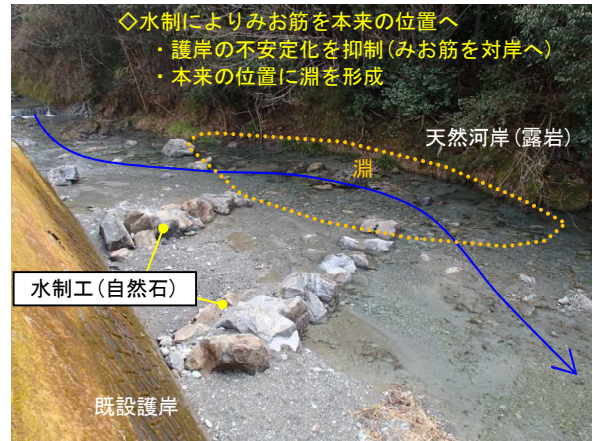
水制設置箇所(工事完了直後)
