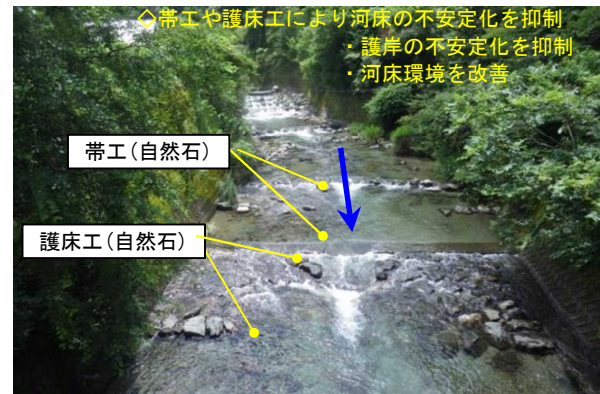
帯工設置箇所(工事完了6ヶ月後)
