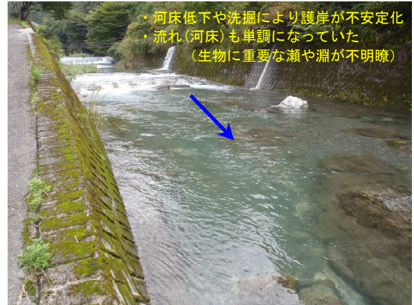
着工前(狩山川:仁淀川町見ノ越)
