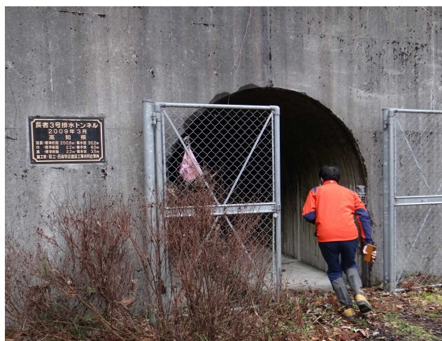
3号排水トンネル
