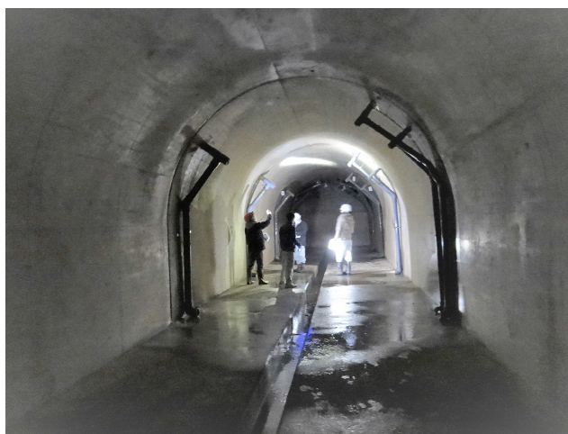
トンネル内の様子
