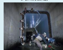
下水道管路の耐震化
