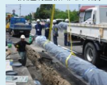
上水道管路の耐震化
