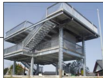
〔津波避難タワー〕
