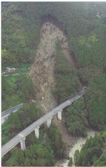
大豊町立川上名地区の斜面崩壊 (高知自動車道の橋梁の流出)
