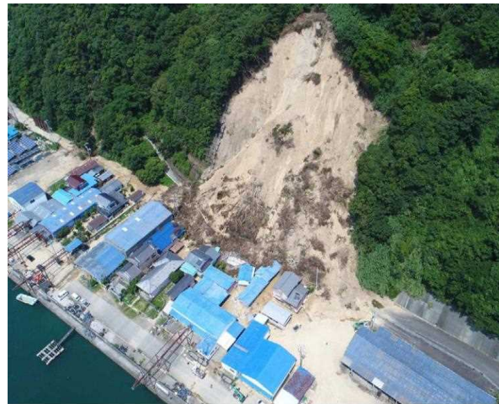
宿毛市大島地区の斜面崩壊 (人的被害や人家の全半壊等の被害が発生)
