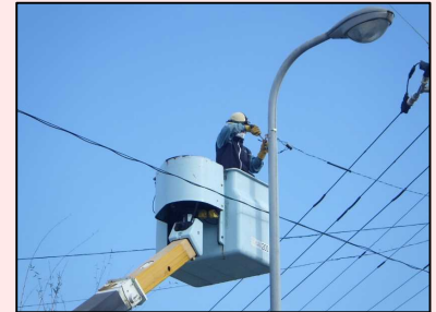
道路照明のLED化の様子
