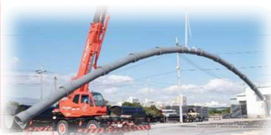
地震の揺れにも対応する耐震管への布設替
