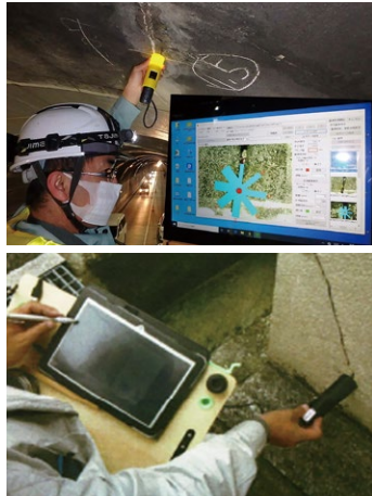
現場での計測風景
