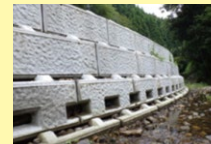
プレキャストコンクリート製品を使用した護岸整備
