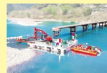
四方十川岩間沈下橋復旧工事
