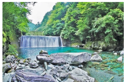
昭和50年仁淀川災害後に砂防堰堤や親水護岸を整備
