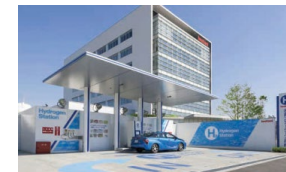
中規模 水素ステーション
