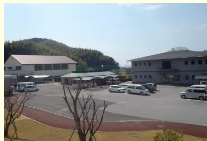
障害者スポーツセンター
