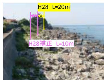
平尾海岸 (施工前)
