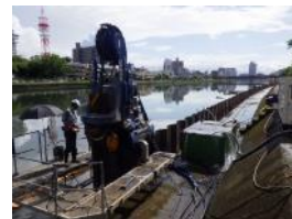
河川堤防の耐震補強状況
