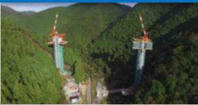
四国横断自動車道 片坂バイパス（黒潮町）
