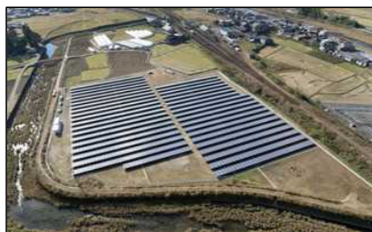
県内の太陽光発電施設
