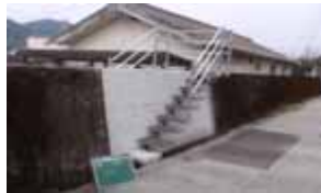
コンクリートによる陸こうの閉鎖
