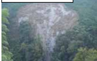
治山対策例(施工前)
