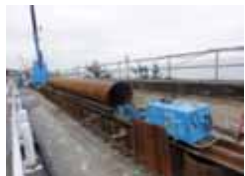
海岸堤防の耐震補強状況
