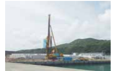
防災拠点漁港の岸壁耐震化
