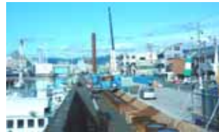
海岸堤防の耐震補強状況
