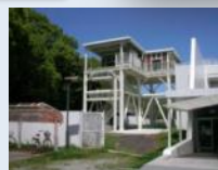
<津波避難タワー>
