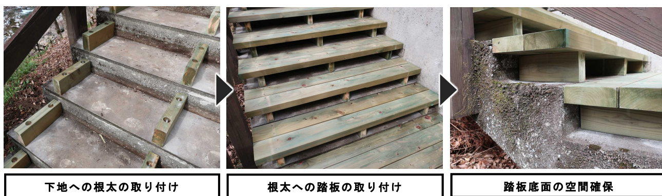
図3 木製階段の修繕状況
