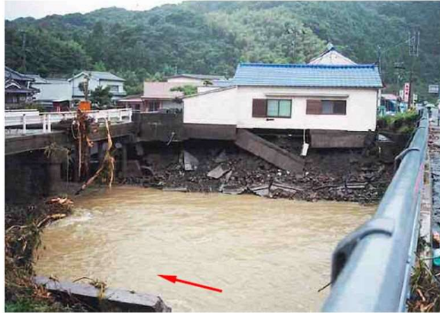
工作物(固定堰)付近で決壊(H13年 貝ノ川川)
