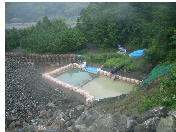
濁水対策のイメージ（沈砂池）
