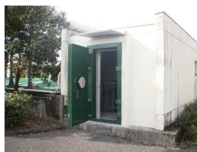
建物内への浸水防止策 (左：防水扉 右：止水板)
