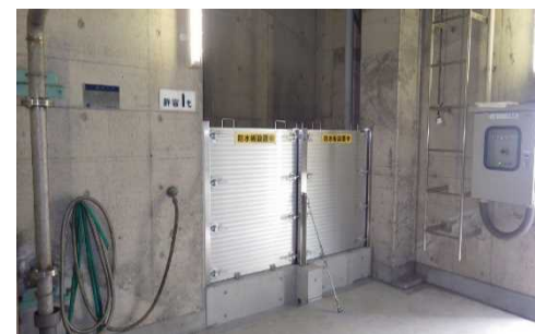
建物内への浸水防止策 (左：防水扉 右：止水板)
