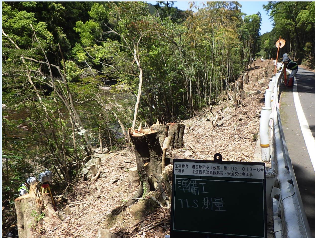
県道宿毛津島線 TLS測量状況
