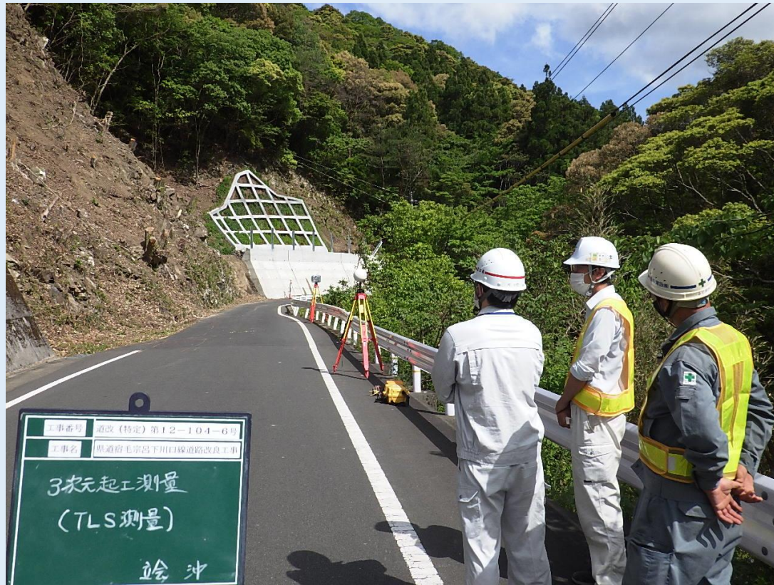
県道宿毛宗呂線 TLS測量状況
