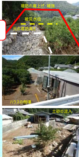
河床掘削や堤防の高上げなどにより 浸水被害を解消
