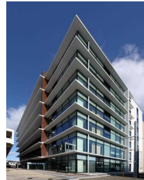
香南市庁舎(7階建て) ※耐震壁にCLTを使用
